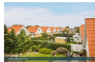
Grønvangsvej og Rahbeks Allé
