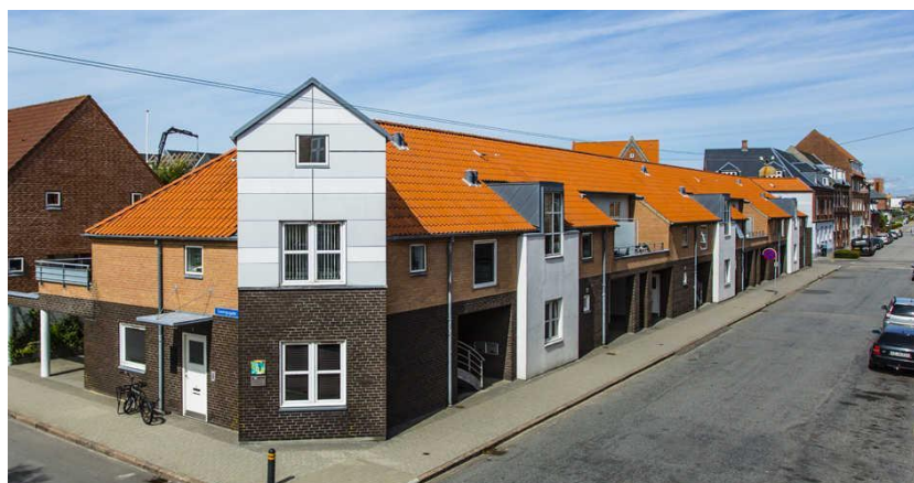
Østergade 46-58, Sverrigsgade 1, Nygårdsvej 8
